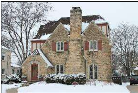
Alfred H. Hebenstreit House, 1932 663 N. 77th Street
